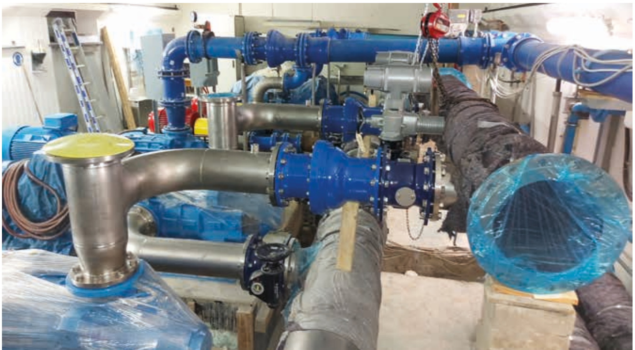
Mise en place de l'un des deux nouveaux collecteurs de distribution
