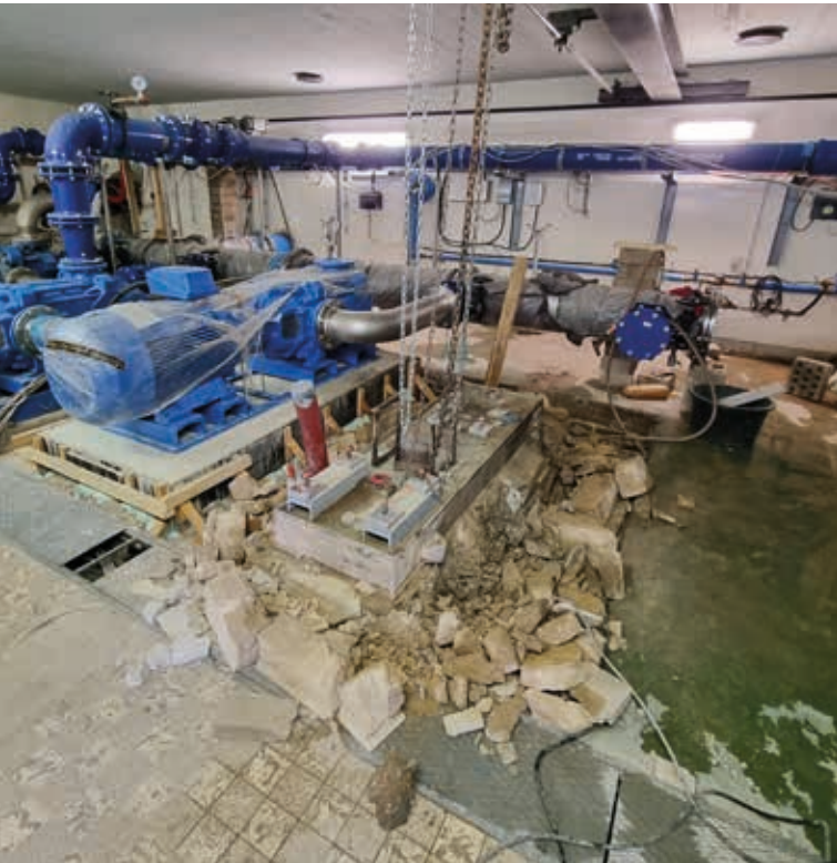
Mise en place d'une pompe à son emplacement définitif, tandis qu'à gauche, une autre pompe continue de fonctionner avec le collecteur provisoire.
