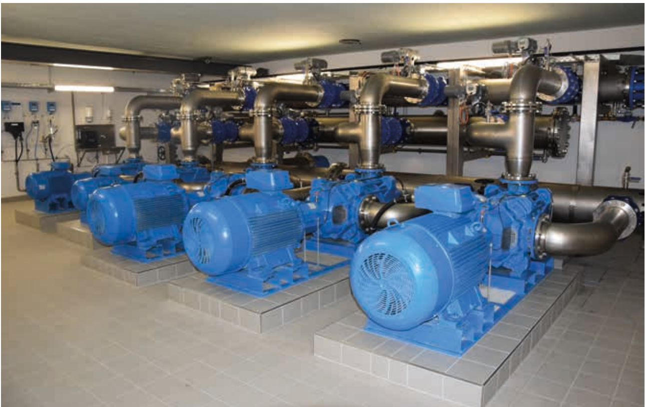
Situation finale de la réhabilitation
